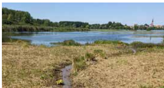
Travaux réalisés sur le Marais de Rumaucourt (62)
