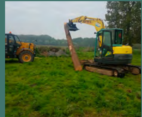
Utilisation d'engins de levage pour le remplacement du mât
