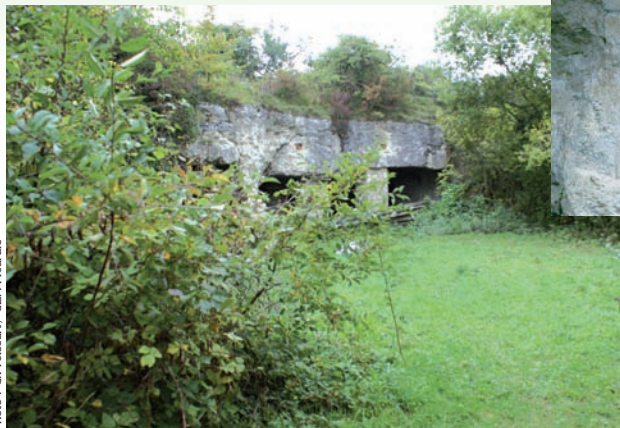
Carrière privée, ancien poste de commandement
