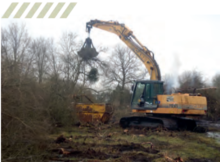
Travaux de déboisement
