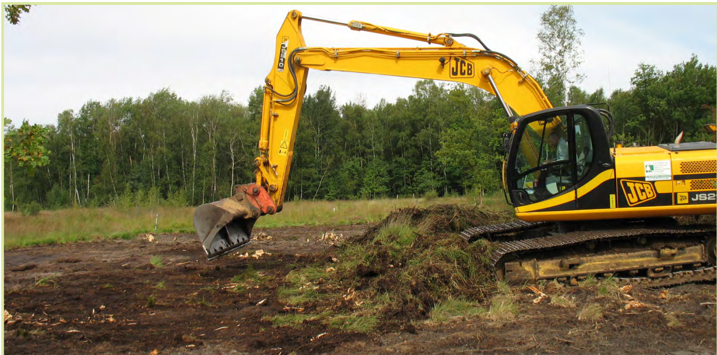
Etrépage mécanique à grande échelle
